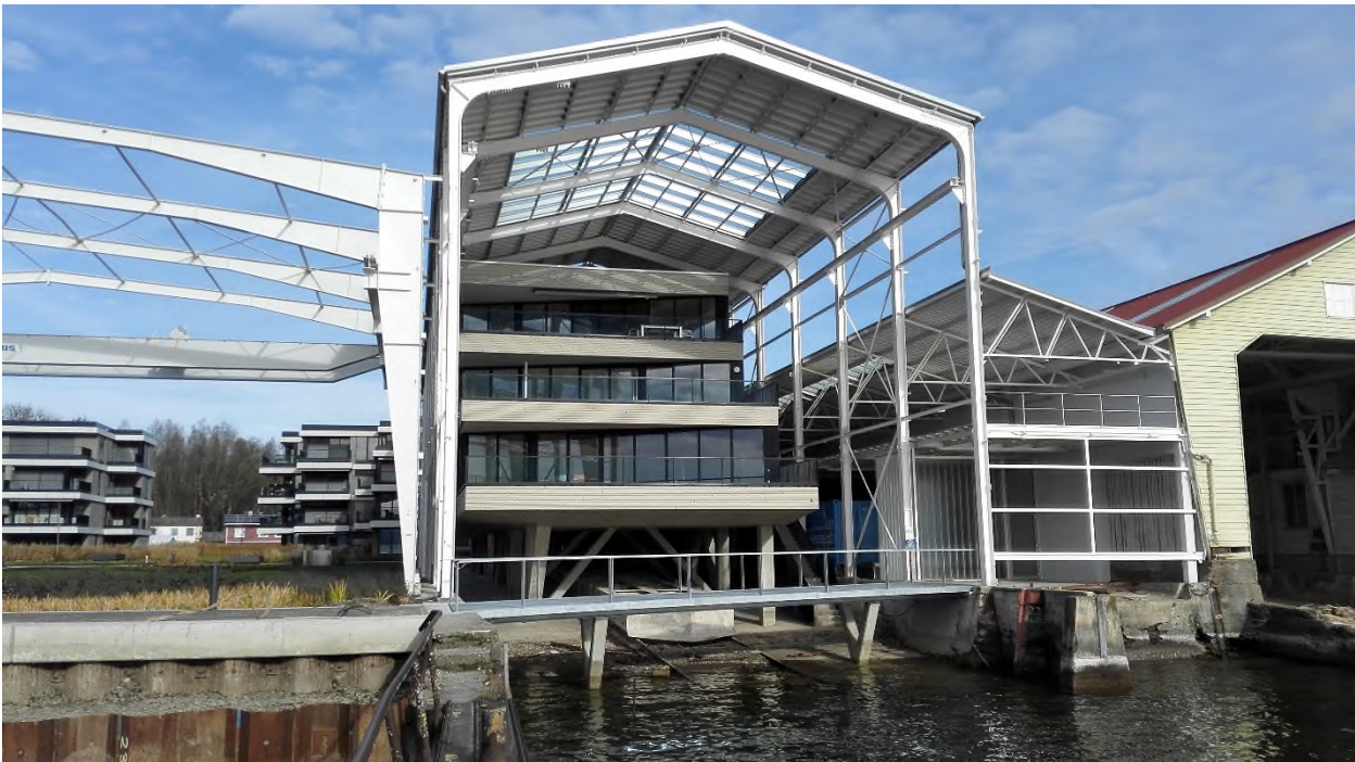
Abbildung 4-2: Aufgeständertes Gebäude Nr. 12 (links) und Verbau zwischen Geb. 11 und 12
