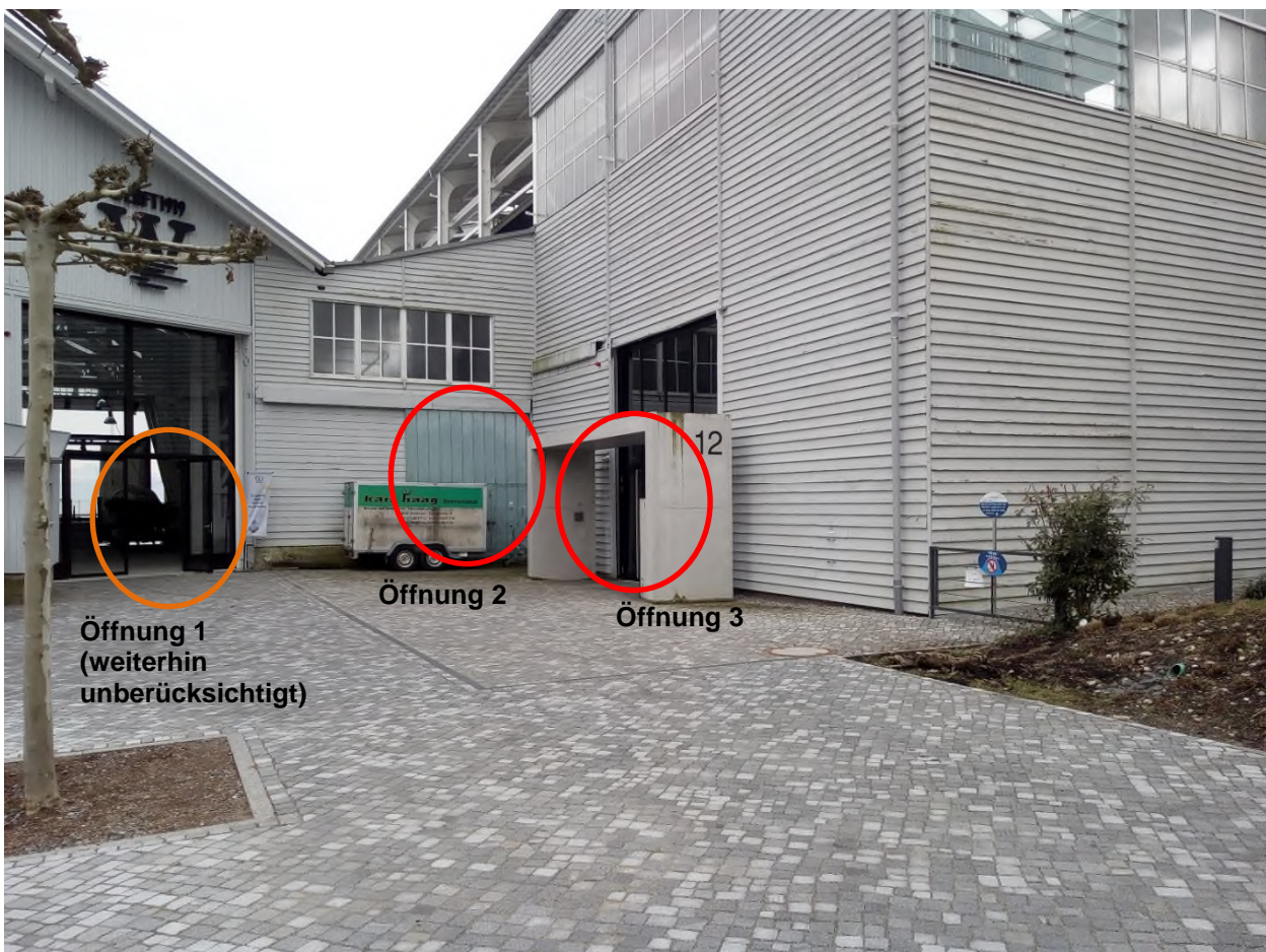
Abbildung 5-6: Offene Tore bei Hausnummer 11 und 12 am Bodanplatz
