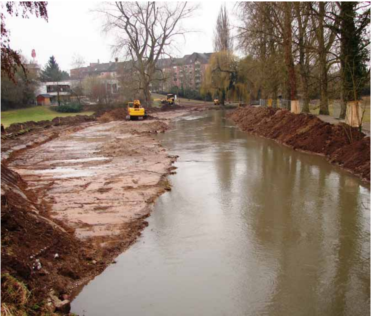
Abb. 4.7: Entfernung der Uferbefestigung und Umgestaltung der Alb in Karlsruhe
