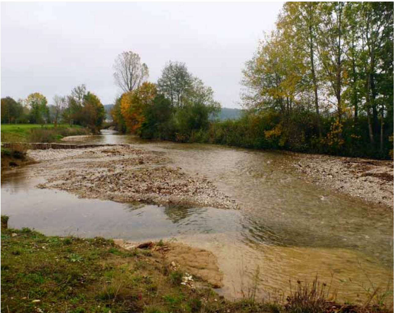
Abb. 4.6: Einbau einer Pfahlbuhne zur Stromlenkung an der Eschach
