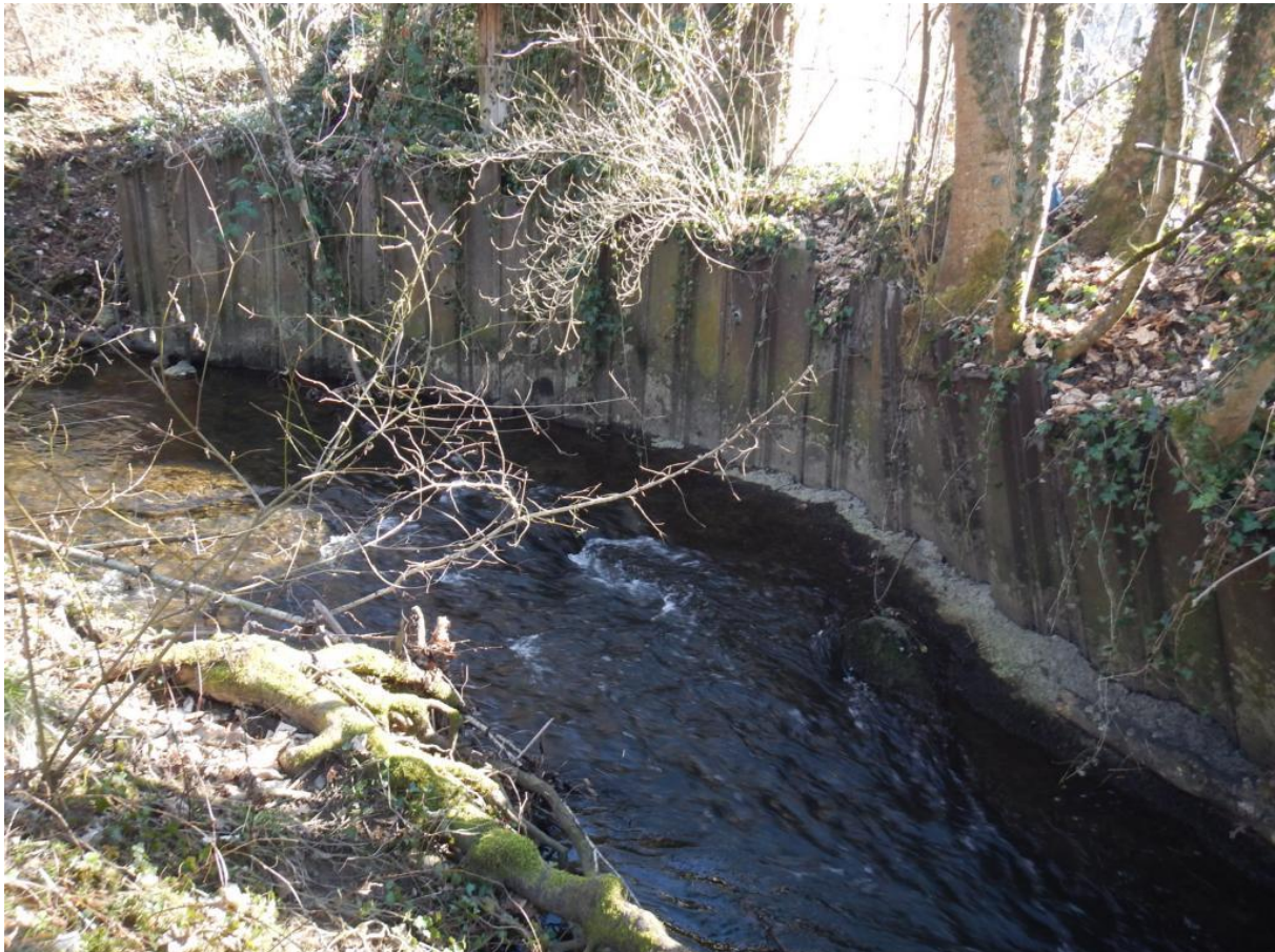
Abbildung 13: Massive Böschungssicherung am Nonnenbach NB028
