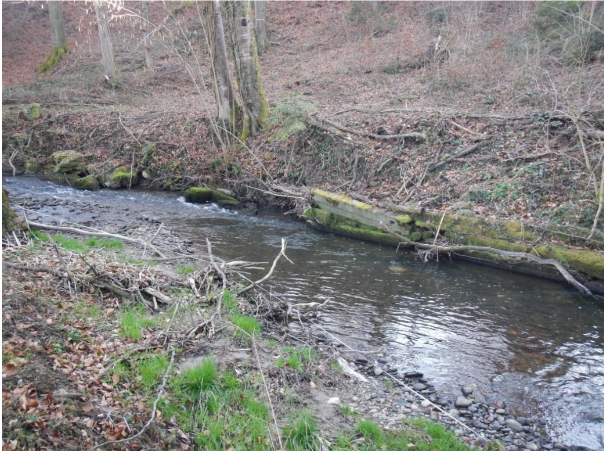
Abbildung 14: Einfacher Uferverbau am Nonnenbach NB042
