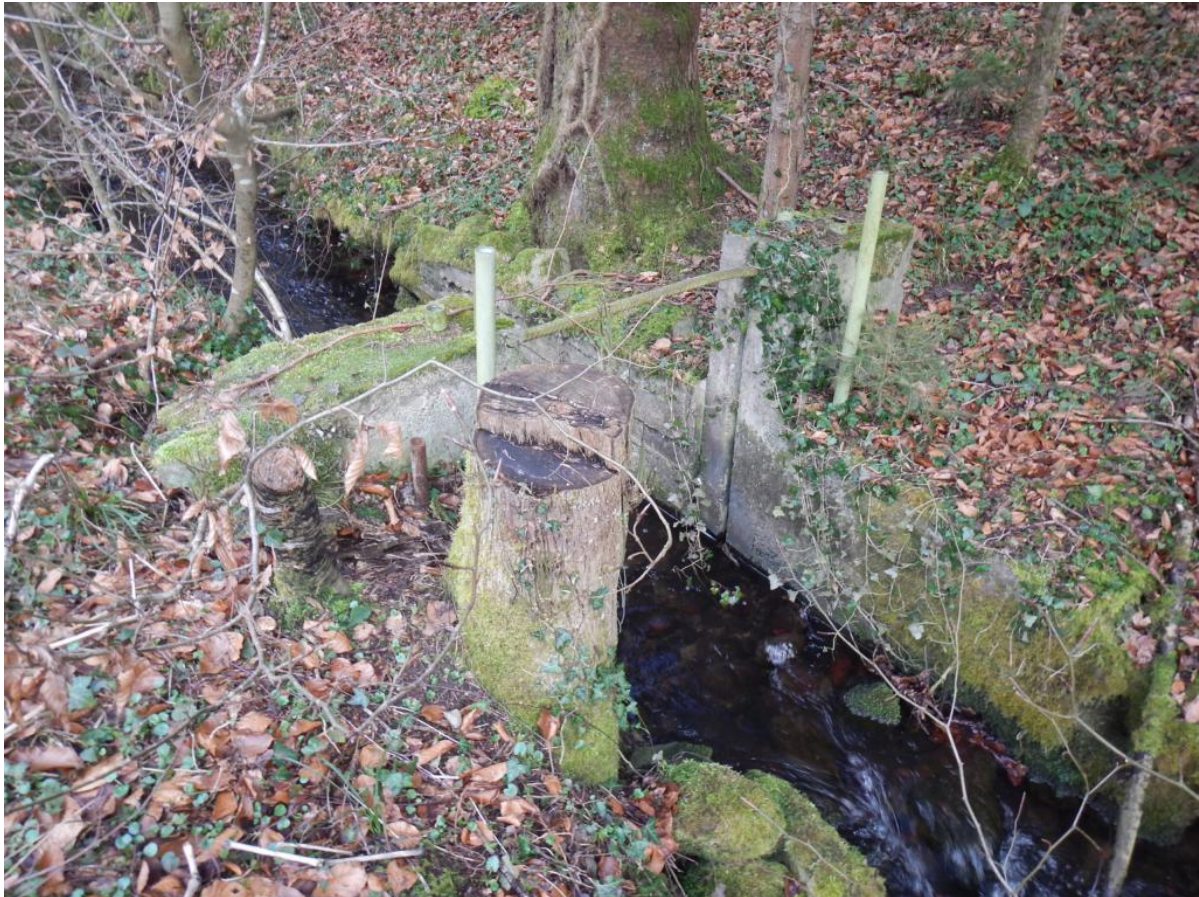
Abbildung 16: Alte Wehranlage entfernen am Betznauer Bach, Abschnitt BB057/BB058
