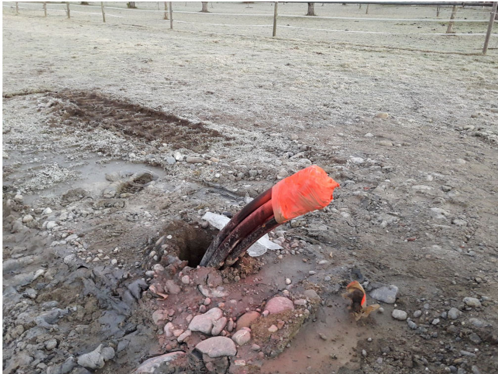
Abbildung 6: Erdwärmesonde vor Aufbau des Messgeräts
