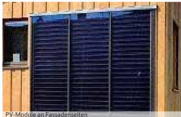
PV-Module an Fassadenseiten
