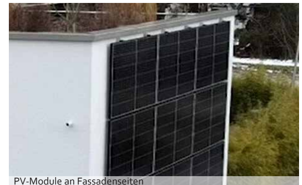
PV-Module an Fassadenseiten
