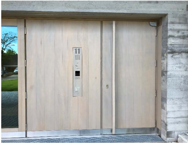
Nebeneingang mit automatischer Türöffnung
